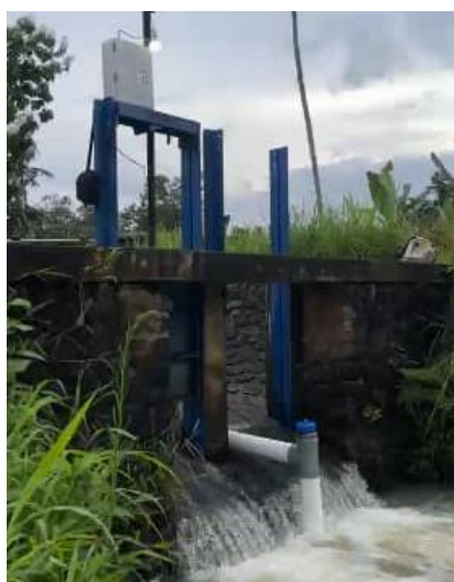
Gambar 9. Prototipe PLTMH di pintu irigasi Desa Lugusari
